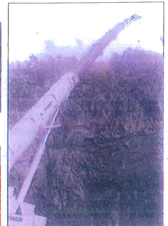
Préparation massif sommet de falaise attendant la mise en place de la conduite forcée... aérienne ! (Flèche de grue : 90 mètres.)
